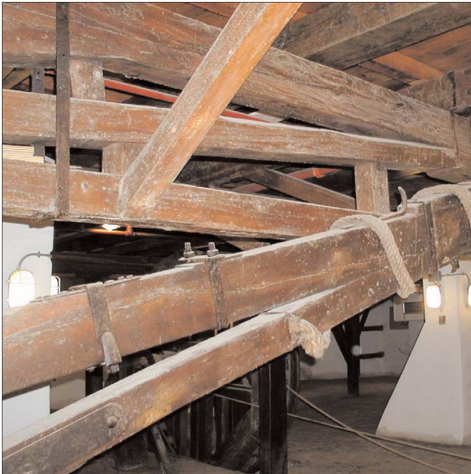
Figura 16. Vista della capriata e della leva intermedia.
