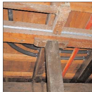
Figura 18. Dettaglio del solaio con evidenziate le due orditure di travi, il tamponamento con il tavolato e il pilastrino rompitratta; è anche visibile l'ometto incernierato all'intradosso della trave longitudinale che all'occorrenza ruota sino alla posizione verticale.
