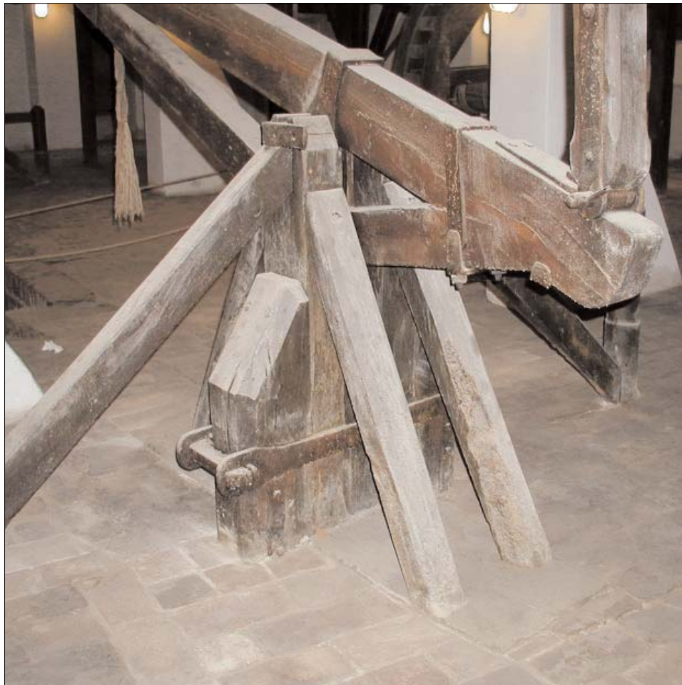
Figura 14. Vista della leva di sollevamento in configurazione di riposo ossia con il braccio lungo sollevato. A differenza dell'altra coppia di leve il supporto non presenta contrafforti ed è alloggiato in un vano incassato nel pavimento.
