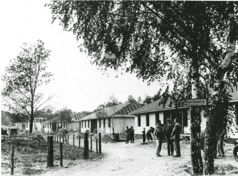
7. Villaggio Olimpico Berlino 1936 in costruzione. Foto del maggio 1935.
