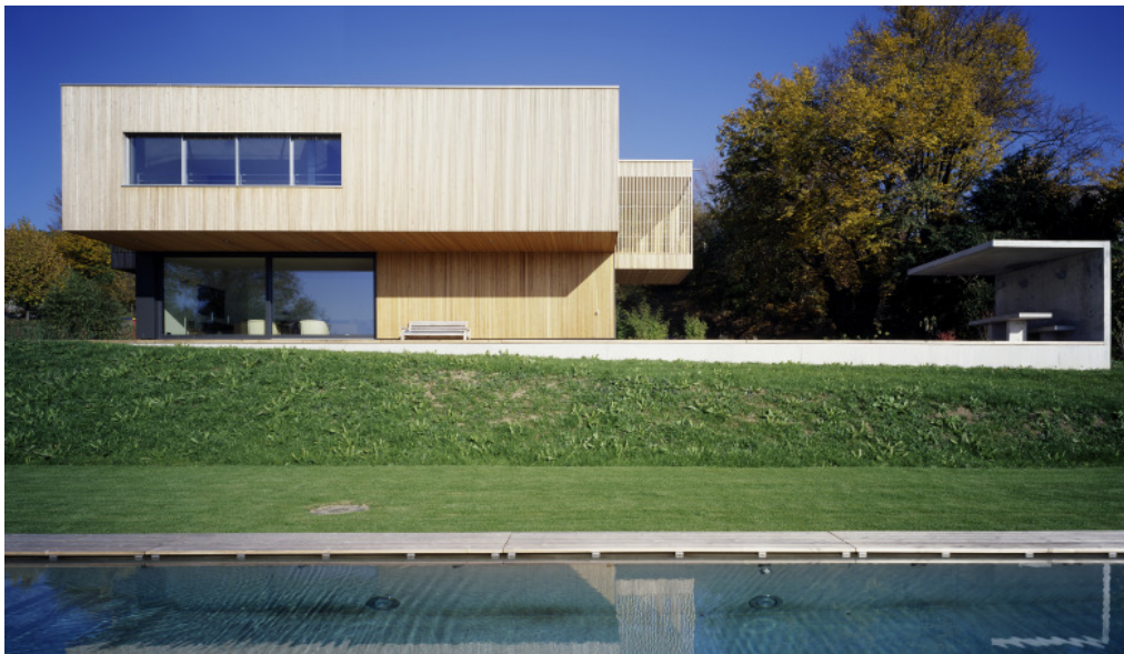
4. Arch. Burkhalter-Sumi, edificio residenziale a Erlenbach, Svizzera. L'edificio è rivestito con legno trattato con protezione nanotecnologica capace di aumentare la resistenza agli agenti atmosferici (Foto cortesia dello studio Burkhalter-Sumi).
