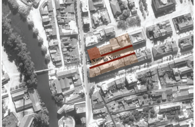
Figura 2. Conjunto dos Estaus. Métrica Arquitectónica e Urbana. Fotografia aérea, Serviços Cartográficos do Exército.
