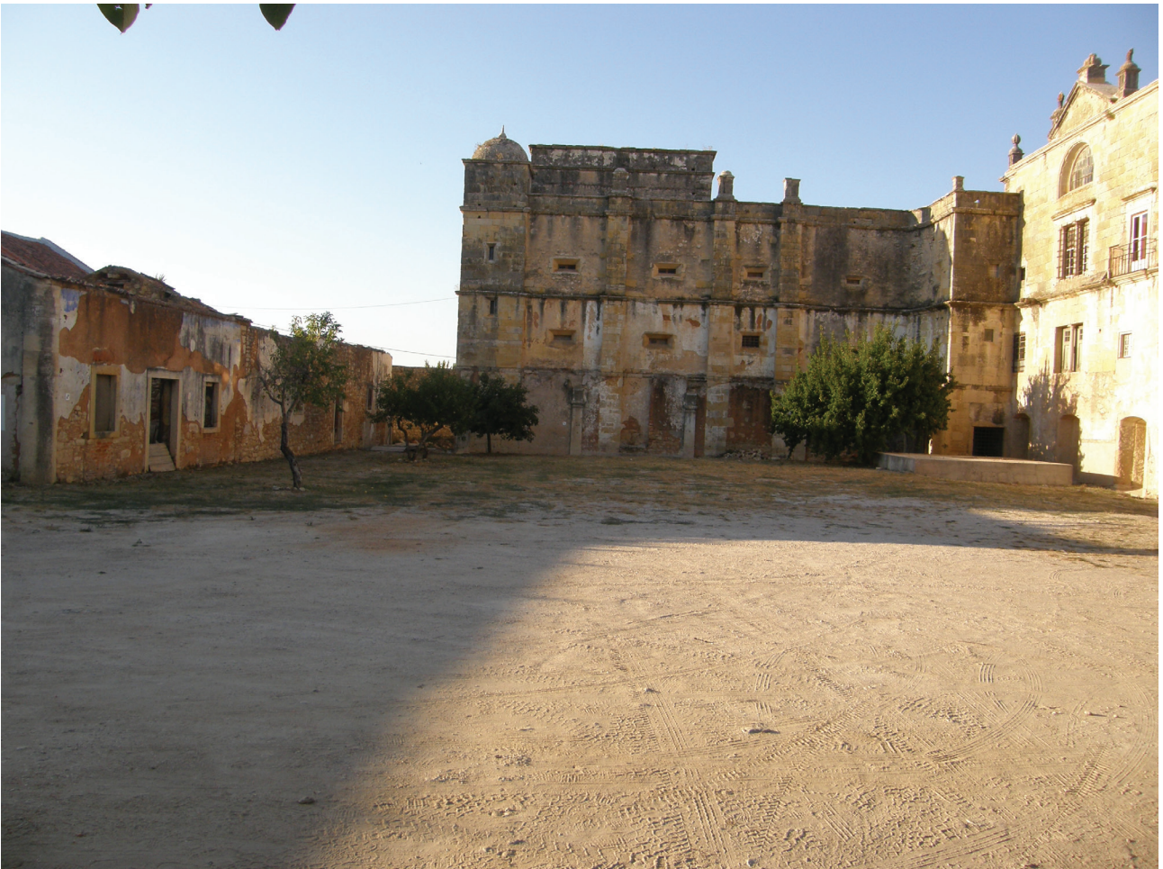
Figura 1: Pátio dos Carrascos e Fachada Sul do Bloco das Necessárias e corredor de ligação aos dormitórios.
