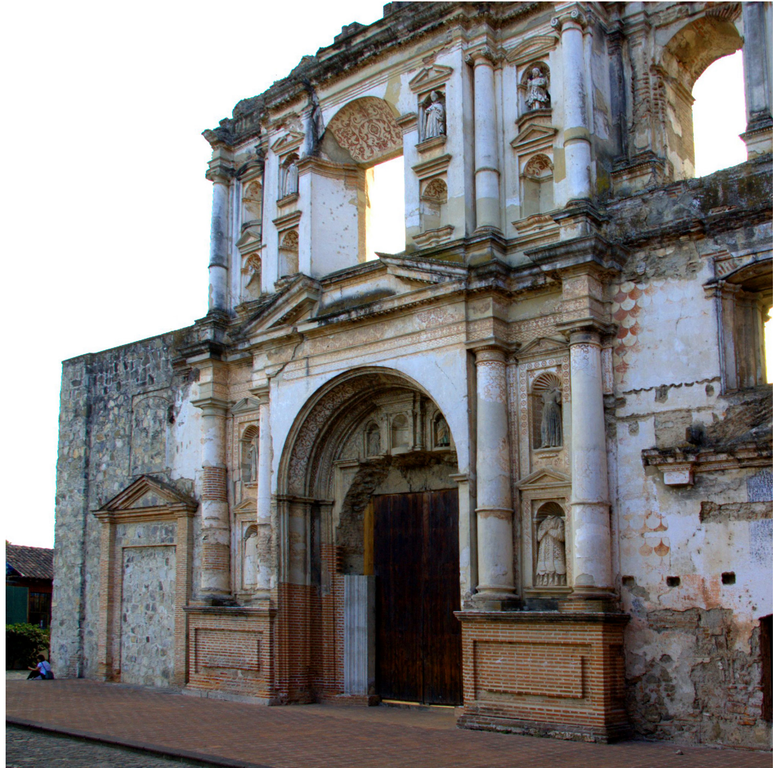
1. La facciata della chiesa della Compañía de Jesús dopo i recenti interventi di consolidamento.
