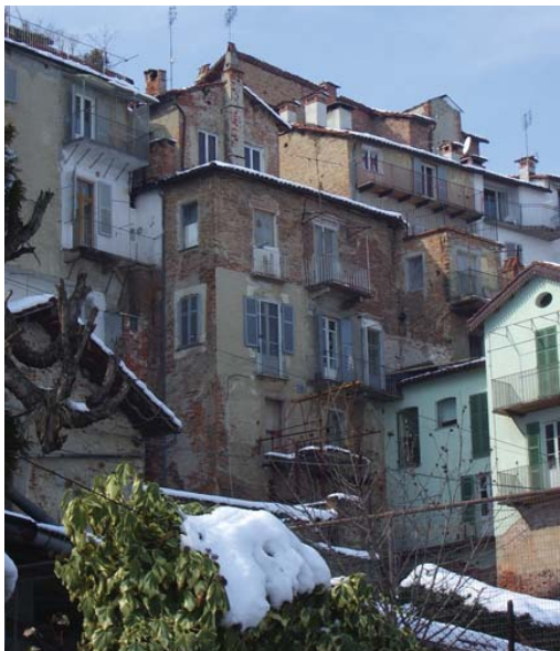
3. Vista del retro dell'edificio di Via Vico.
