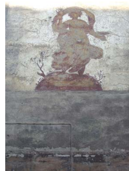
5. Un particolare dell'apparato decorativo di facciata realizzato ad affresco.
