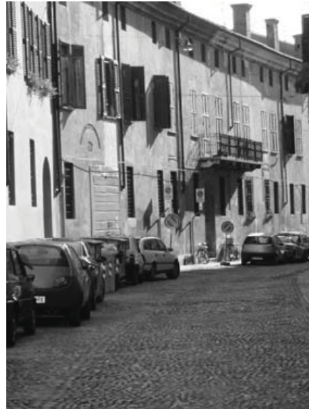
2. Caratteri ambientali di centro storico.
